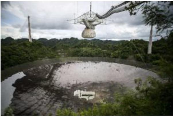
**2017г 20 сентября 2017 года разрушительный атлантический тропический циклон - ураган «Мария» (Hurricane Maria) уничтожил радиотелескоп "Аресибо", - сломал пополам 29-метровую радарную антенну радиотелескопа «Аресибо», её обломки пробили главное зеркало телескопа и повредили вспомогательное.**
